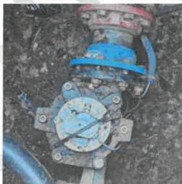
2. Un compteur télégéré en direction de la Commune de Gilhoc sur Ormèze, situé dans la chambre des vannes du réservoir du Col des Fans », de diamètre 100.
